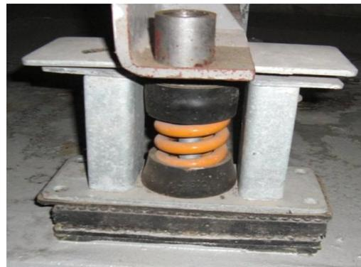
圖 8 機座底部加裝防振設備
